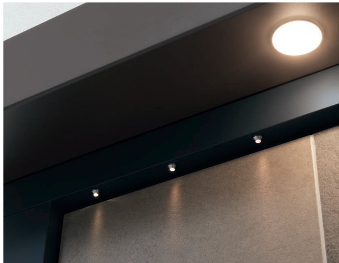
Blendrahmen / LED-Lichtpunkte im BLOCKthermprofil 22985 / 22980
